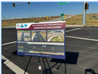
SR 120McKinley - Interchange.jpeg
